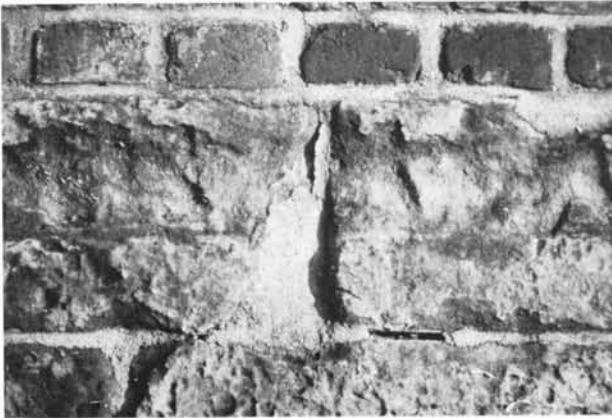
Figuur 5. Veel voegen tussen oude mergelblokken heeft men tijdens de restauratie oppervlakkig met Portland-cement dichtgezet (Foto: B. Kruyntjens).
