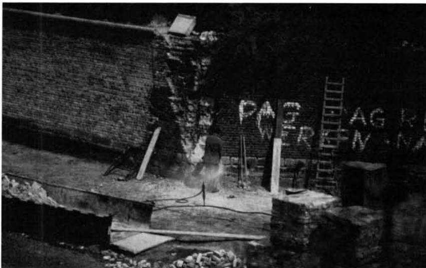
Figuur 2. Gebruik van pneumatische hamer bij de restauratie van de holle flank van Erfprins-West; 1981 (Foto: B. Kruyntjens).
